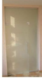
Ganzglasanlage mit Sandstrahlung
