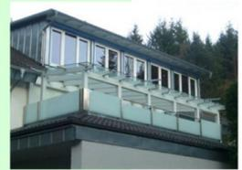
Selbstreinigendes Glasdach mit Markise und vorgehängter Brüstungsverglasung
